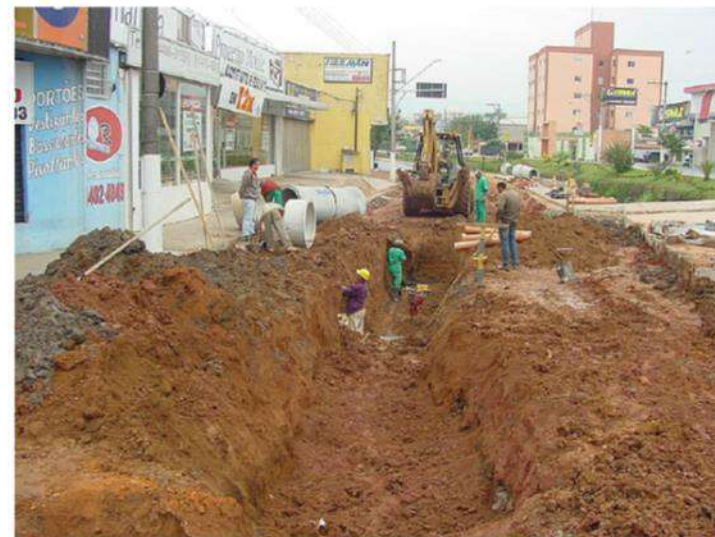
RECONSTRUÇÃO DE COLETOR DE ESGOTO - RUA JOVIANO ALVIM
